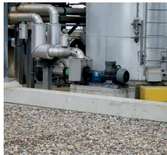
Baureihe CNH-B 50-200G-W20, Förderdaten 60 m 3 /h, Medium Glykol/Wasser, Prozess Kühlsystem
