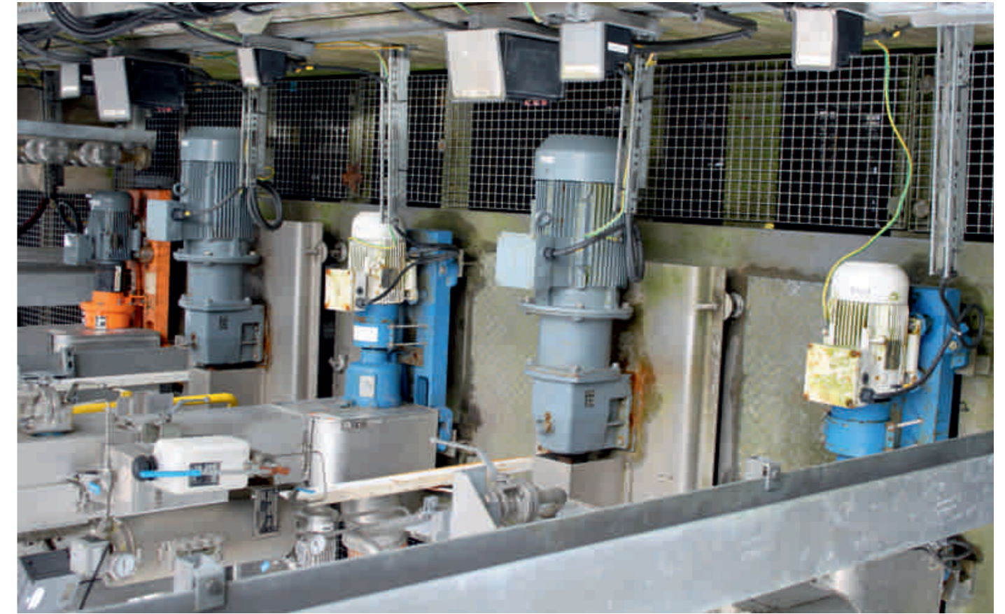
Baureihe CMAL 32-200/1, Förderdaten 15 m 3 /h, 1,2 bar, Medium Natronlauge (50%ig), Prozess LKW-Entladung Baureihe AK440-227-12, Förderdaten 30 m 3 /h, 1 bar, 30 °C, Medium wässriges Polycarboxylat, Prozess LKW-Entladung Baureihe CMAL 32-200/1, Förderdaten 15 m 3 /h, 0,9 bar, 40 °C, Medium Phosphorsäure (75%ig), Prozess LKW-Entladung Baureihe AK450-334-08, Förderdaten 40 m 3 /h, 2,5 bar, 80 °C, Medium Polyethylenglykol, Prozess LKW-Entladung
